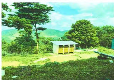
Foto 5: Sustitucion de cubierta de laminas
