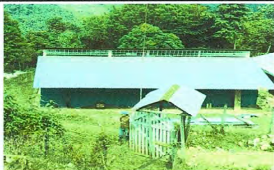
Foto 1: Cubierta de laminas nuevas
