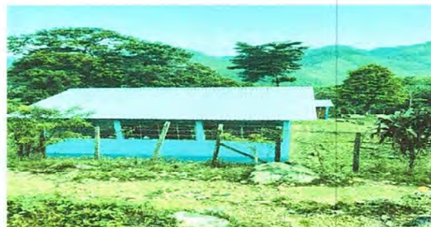
Foto 2: Pintura nuevas en muros
